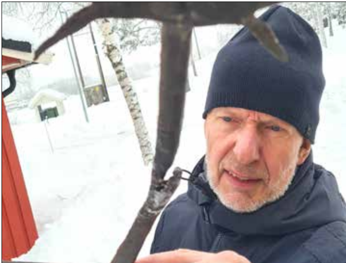
Prosjektleder Harald Ringstad studerer skadene på spiret.
