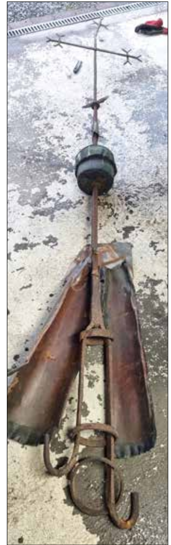
Spiret har en rekke skader som må repareres.
