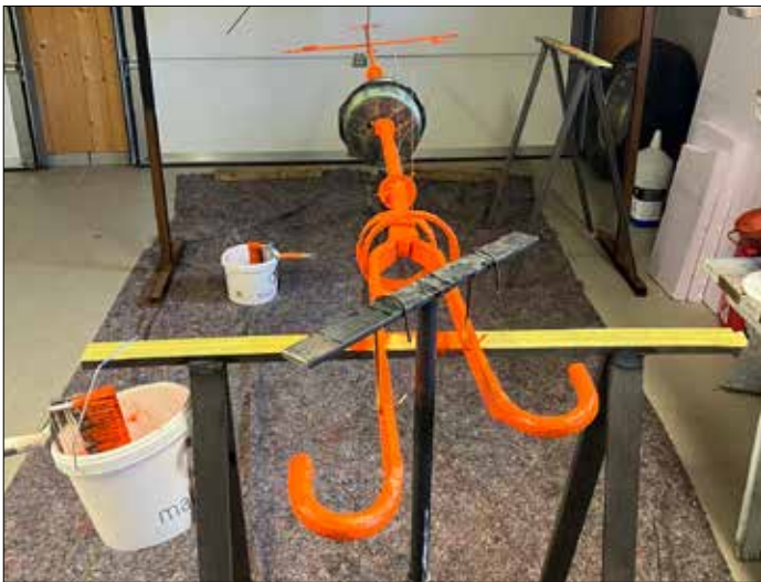
Restaurering av spiret. Det har etter ti dagers tørketid fått påført strøk nr. to av blymønje. Så venter to lag med jernglimmer og så til slutt tre lag med kokt linolje.
